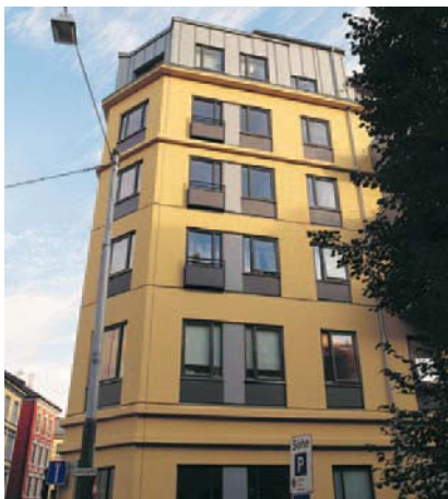
Bygg med bærende fasadelementer
