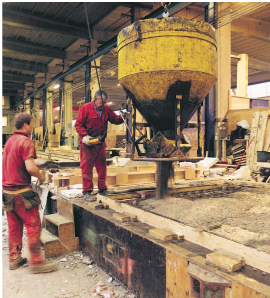
Støping av yttervange for sandwichelement.
