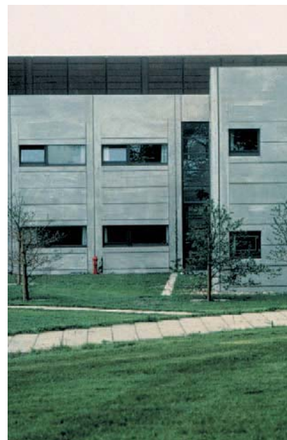
Fasadelementer som går over flere etasjer.
