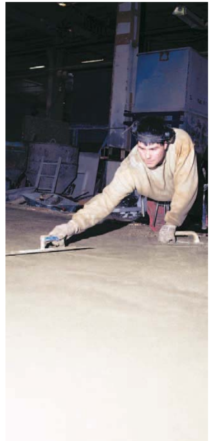
Til slutt pusses innervangens overflate før herding.
