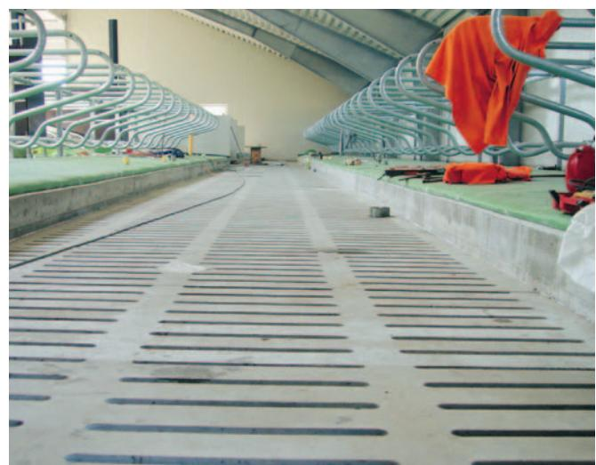
*Bygningen kan tas i bruk kort tid etter at betongelementene er montert.*
