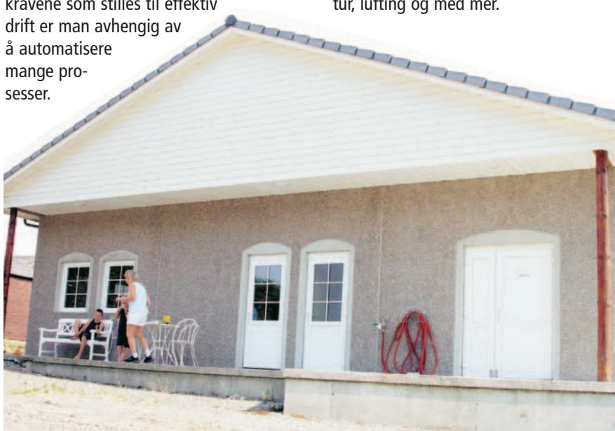
Hønsehus i betongelementer med detaljer som gjør at det harmonerer med lokal byggeskikk på Jæren. Fasadene er utført i frilagt singel og grå sement.
