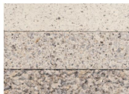
*Frilegging av tilslaget oppnås ved at man vasker bort sementslammet i overflaten slik at tilslagsmaterialet trer tydelig frem.*
