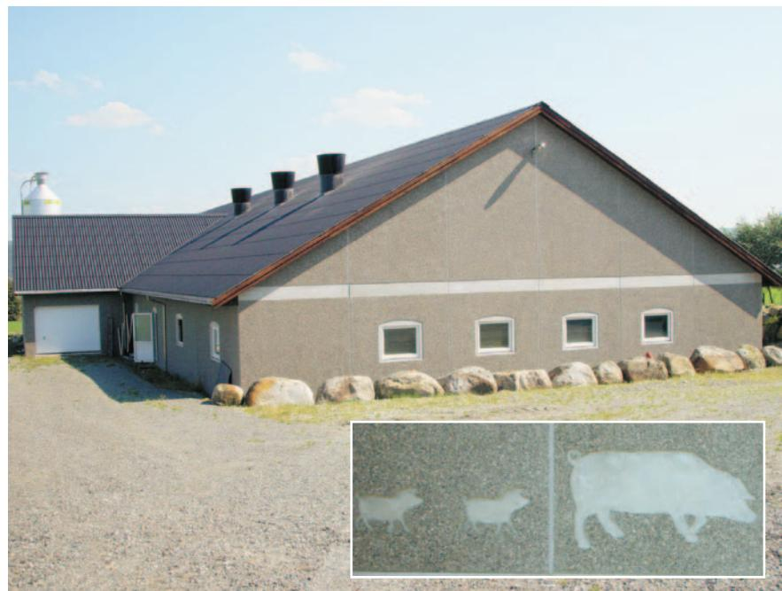
man stor fleksibilitet, og kan møte nye krav og utfordringer uten å måtte gjennomføre tunge ombygginger av driftsbygningen. Et bygg basert på betongelementer vil gi dyrene et stabilt miljø, der betongkonstruksjonen i seg selv fungerer som et varmelager. På
