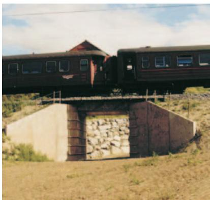
Ved å velge kulverter og broer fra en betongelementfabrikk sikrer man at man har en bro med riktig kapasitet, som er lite vedlikeholdsrevende, og som monteres og er klar for drift på svært kort tid.
