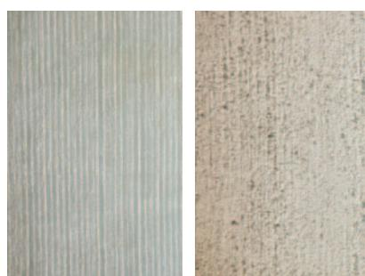
*Kosting, rulling og stoppling av ferskstøpt betongoverflate gir en grov og robust overflate med gode skyggemerkirks.*
